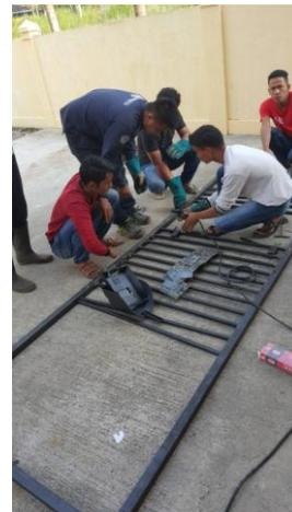
Gambar 13. Proses Penyambungan
