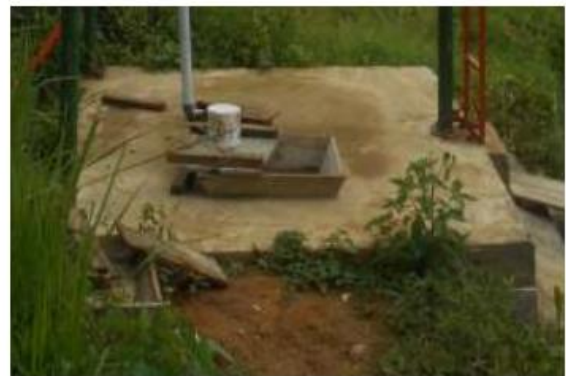
Gambar 10. Rekonstruksi Pondasi Kincir Angin
