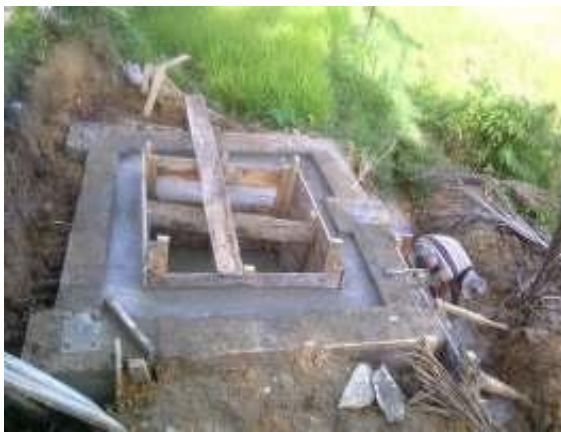
Gambar 9. Rekonstruksi pondasi sumber mata air
